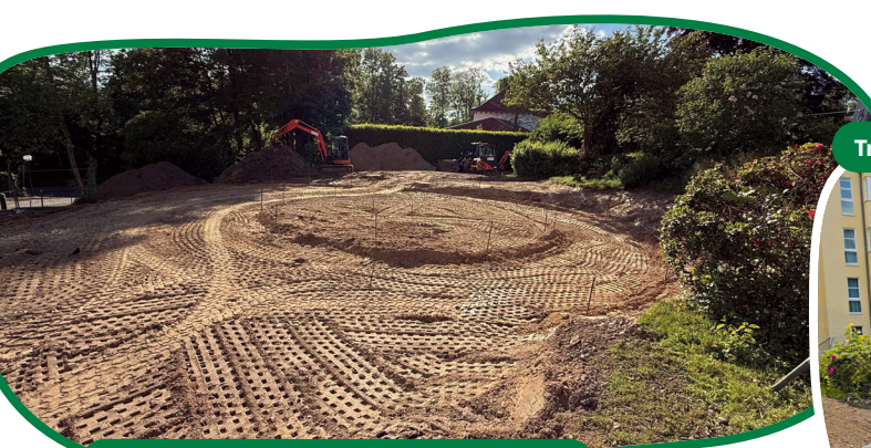
Erdarbeiten zur Angleichung des Geländes
