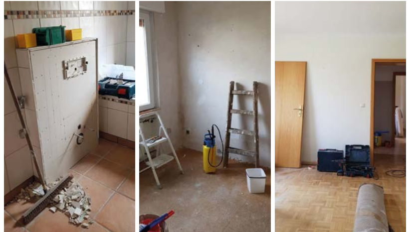
Renovierung in Unterscheideweg 13 – ein Aufgabenfeld für das Arbeitstraining
